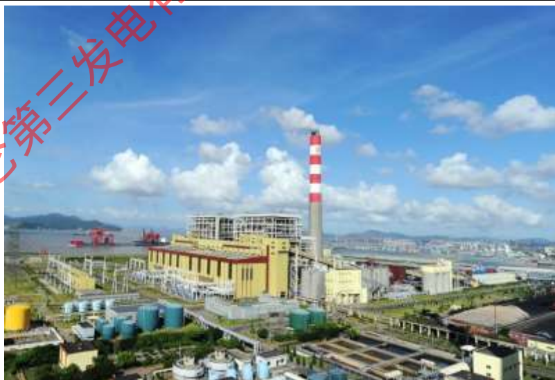
国能浙江北仑第三发电有限公司全景
